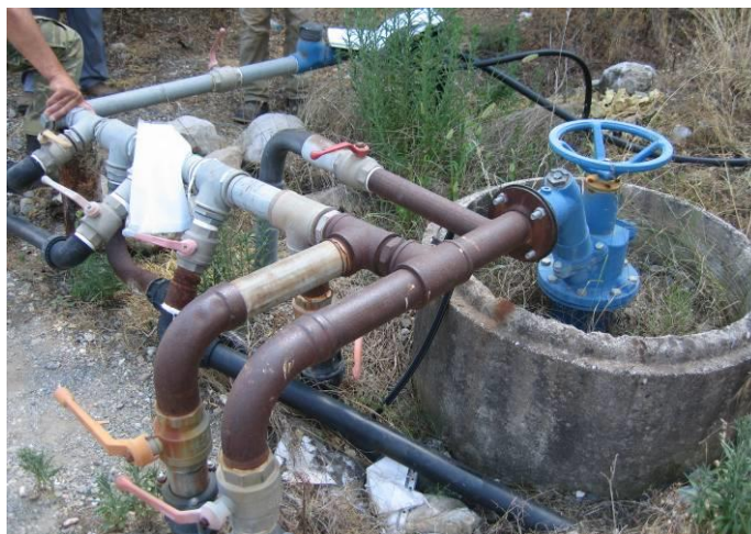
Εικόνα 1: Υδροληψία με δυνατότητα εγκατάστασης 4 υδροστομίων και υφιστάμενη υδροληψία στο δίκτυο Σοχά-Καλυβίων
