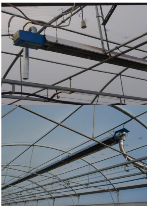
Εικόνα 6: Το σύστημα υπέρυθρης θέρμανσης (IR)
