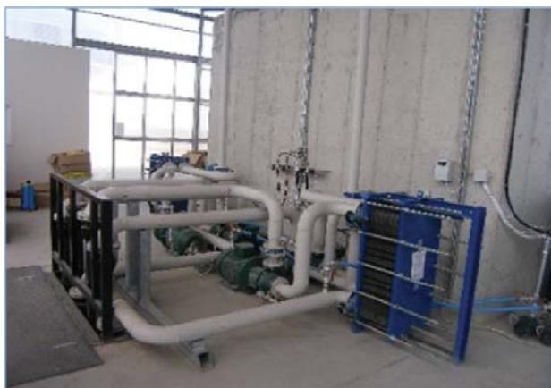
**Εικόνα 5:** Κεντρικός θερμικός σταθμός με τους πλακοειδείς εναλλάκτες θερμότητας.
