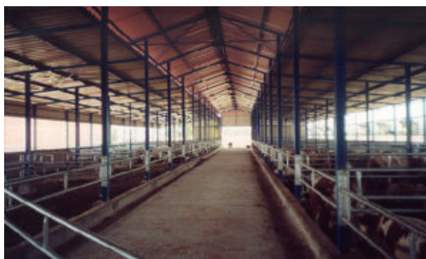
Εικόνα 1. Κατασκευή Βουστασίου μεταλλικού σκελετού ( www.geothermiki.gr )
