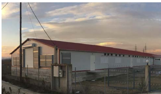
Εικόνα 2. Πτηνοτροφικός θάλαμος μεταλλικού σκελετού και κάλυψης με πάνελ ( www.gaiasergon.gr )
